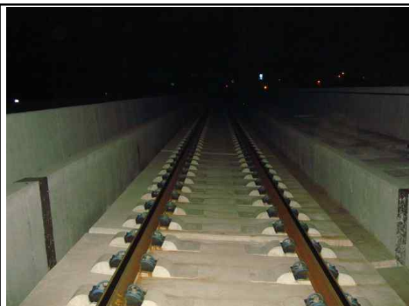
태성고가(T1) 하부 전경
