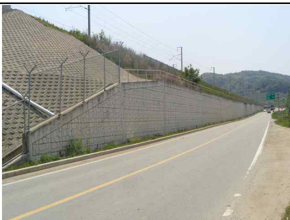
역T형 옹벽 (T2, 우) 시점측 전경
