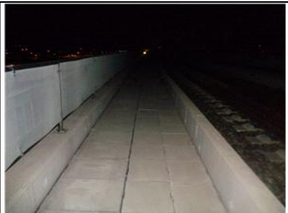
오송2교(T2) 상부 전경
