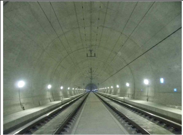
학천터널 내부 전경
