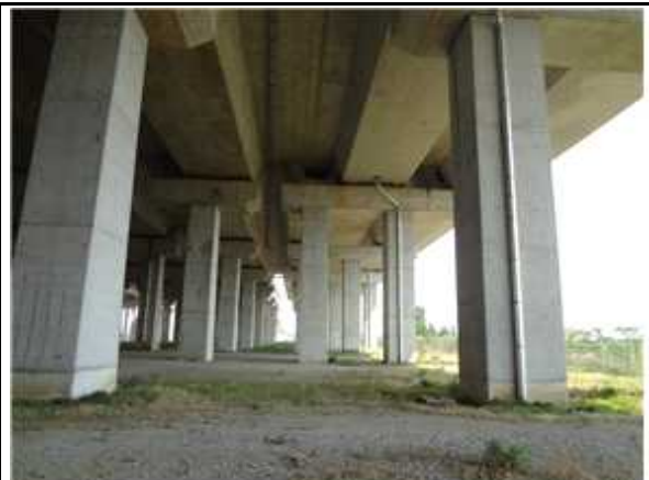
오송2교(T1) 하부 전경
