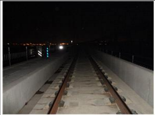
오송고가(T1, 미호천) 상부 전경
