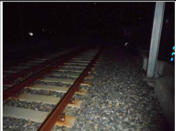
오송1교(T2) 상부 전경
