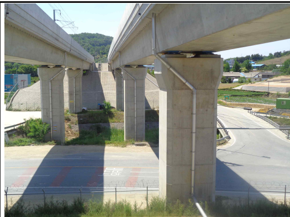
태성고가(T2) 하부 전경
