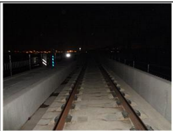
오송고가(T2, 미호천) 상부 전경
