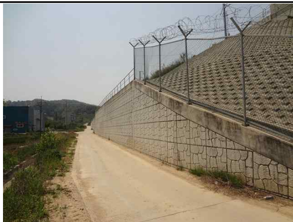
역T형 옹벽 (T1, 좌) 시점측 전경
