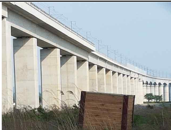
오송고가(T1, BRT) 측면전경
