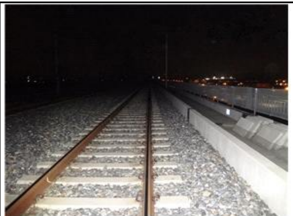
오송역(T2) 상부 전경
