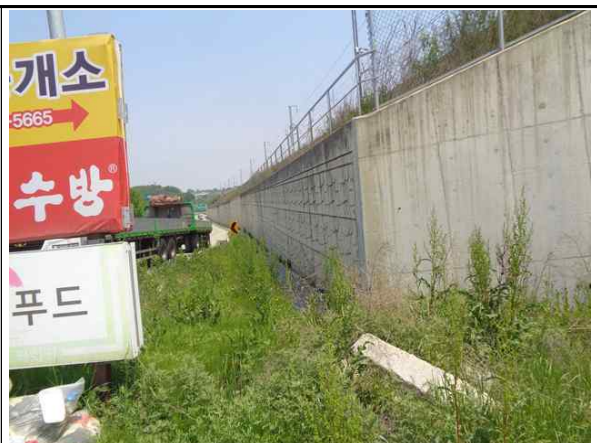
역T형 옹벽 (T2, 우) 종점측 전경
