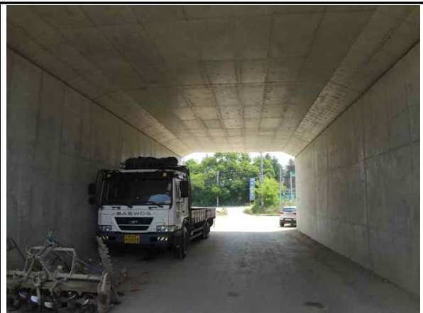
암거 B(라)산단 내부 전경
