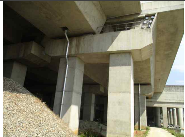
오송1교(T2) 하부 전경
