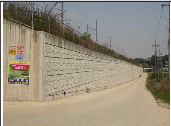
역T형 옹벽 (T1, 좌) 종점측 전경
