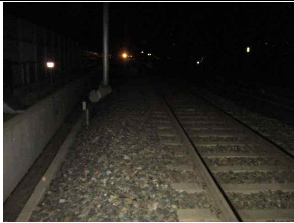
오송1교(T2) 상부 전경
