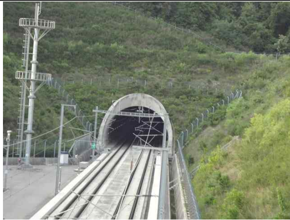
학천터널 입구 전경
