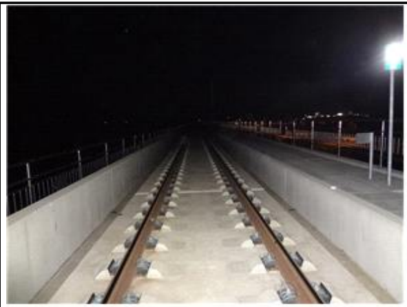
오송고가(T1, BRT) 상부 전경
