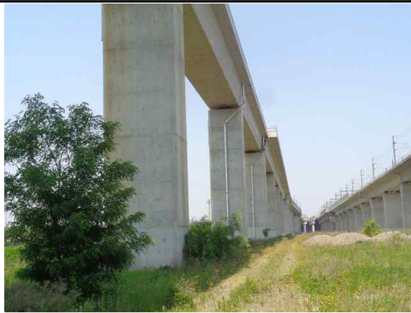
오송고가(T2, BRT) 측면전경
