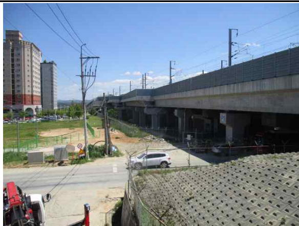
오송1교(T2) 측면 전경
